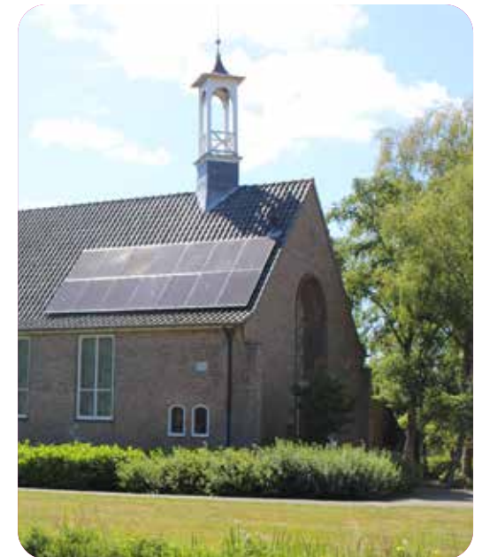
voorbeeld van kerkdak met zonnepanelen
