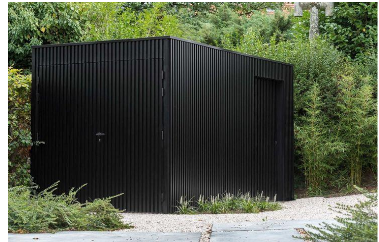
berging sober en ondergeschikt aan de woningen
