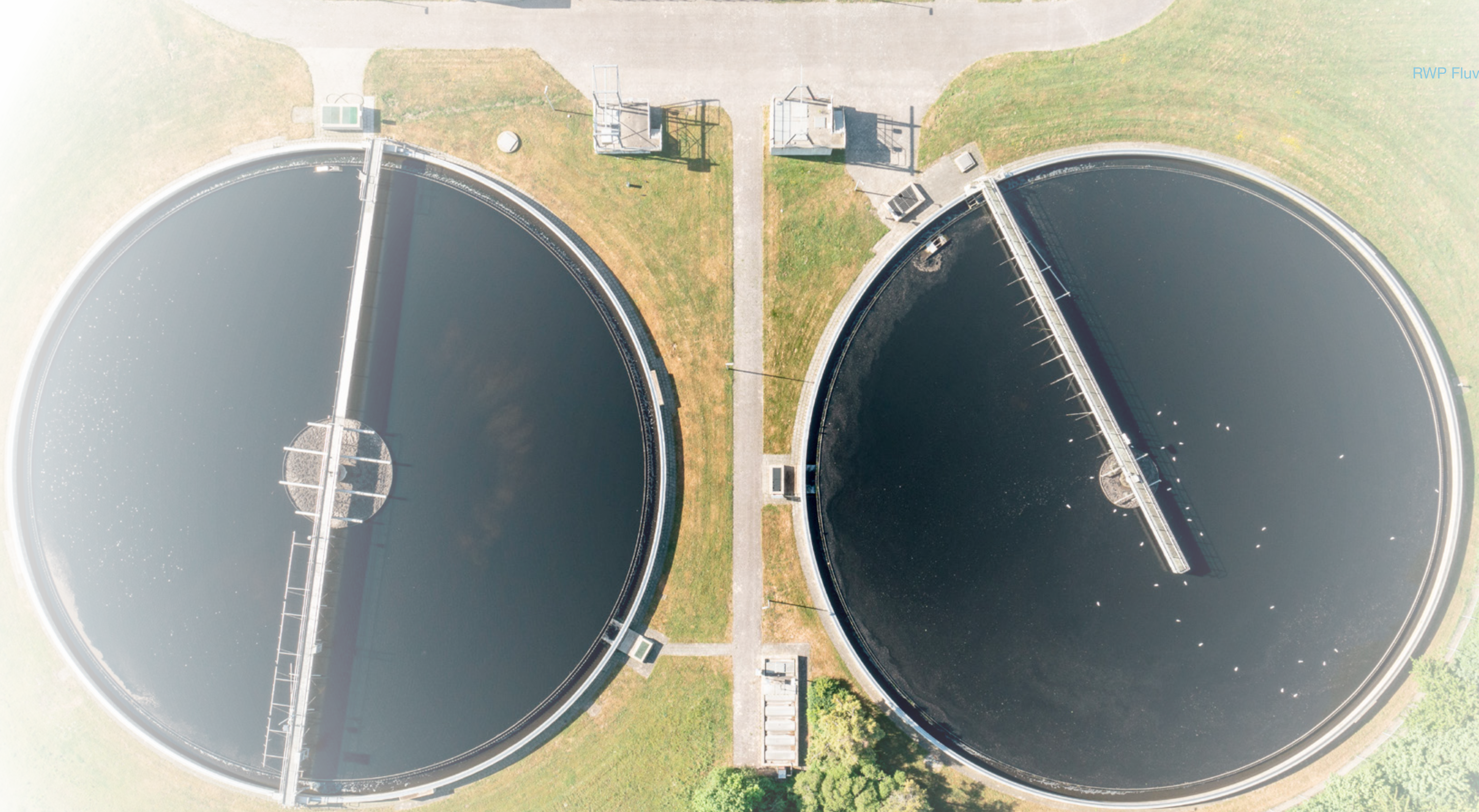
Nabezinktanks RWZI, Dieverbrug
