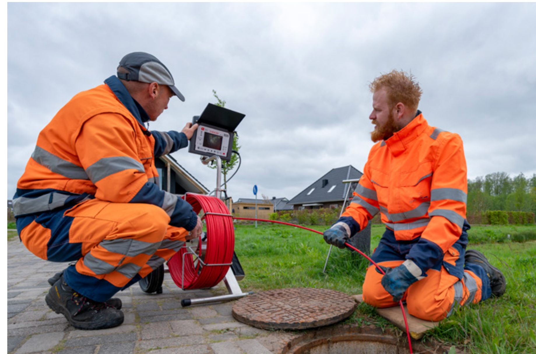
Rioolploeg en camera inspectie riolering
